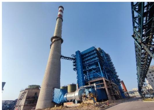
图 4.1—23 球团焙烧烟气净化系统
