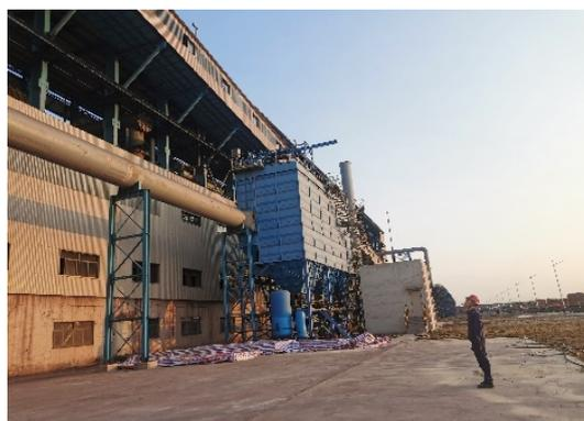
图 4.1—24 造球和铺底料除尘系统
