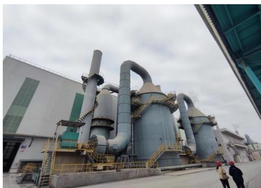
图 4.1-132 钢渣处理生产线湿式除尘系统
