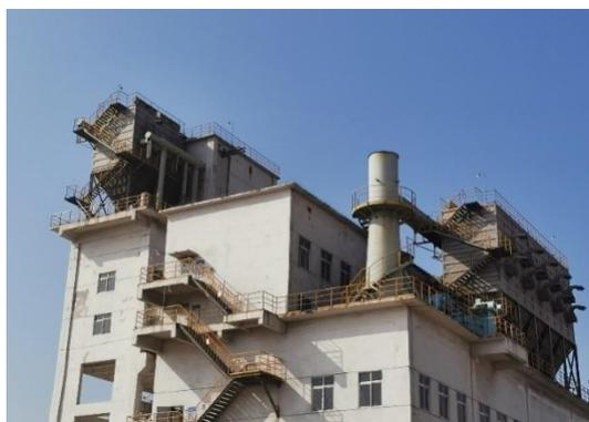
图 4.1-29 备煤筛分粉碎室除尘系统（右），备煤 103 转运站除尘（左）
