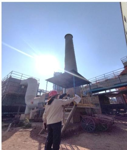
图 4.1—20 1 号混合机混料水除尘系统
