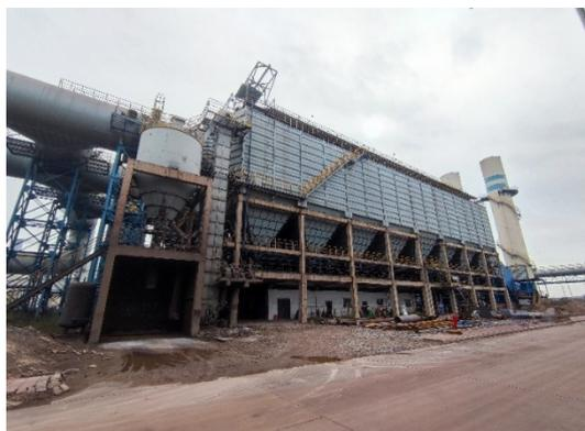
图 4.1—74 炼钢二车间 LF 炉、RH 炉及上料系统除尘
