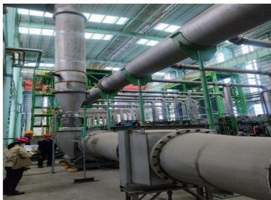
图 4.1-109 1#热镀锌机组清洗段碱雾净化
