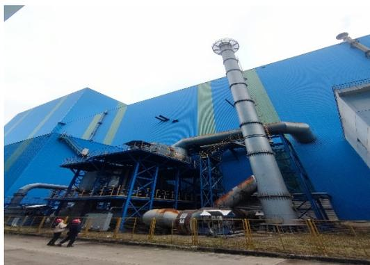
图 4.1-106 1#热镀锌退火炉排气筒
