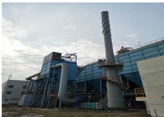
图 4.1-51 2#高炉炉顶除尘系统
