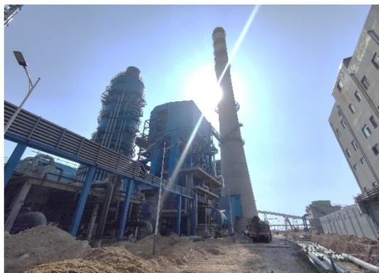
图 4.1-13 1 号烧结机头烟气净化系统
