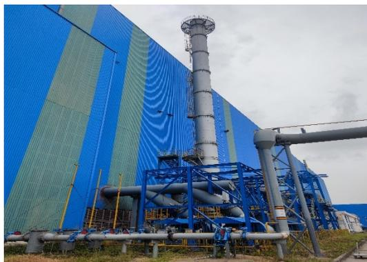
图 4.1-105 连续退火炉排气筒
