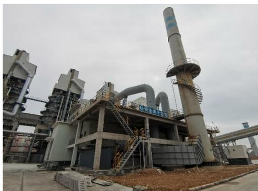
图 4.1-78 3#、4#石灰窑废气处理系统
