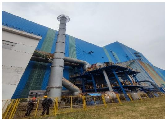
图 4.1-107 2#热镀锌退火炉排气筒
