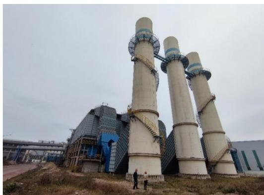
图 4.1—68 炼钢铁水预处理除尘（中间为铁水预处理）
