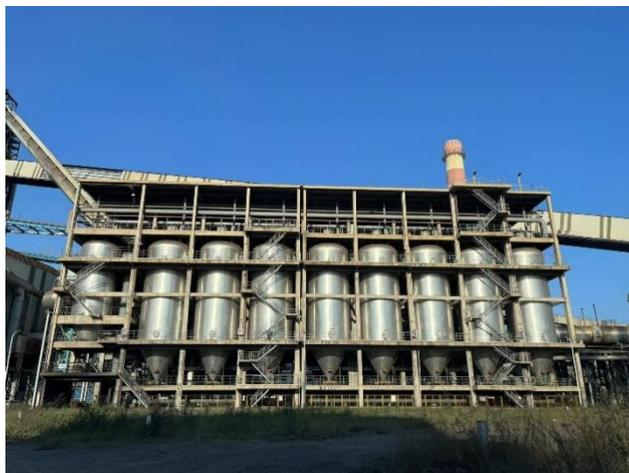
图 4.1—62 1号高炉煤气干法除尘
