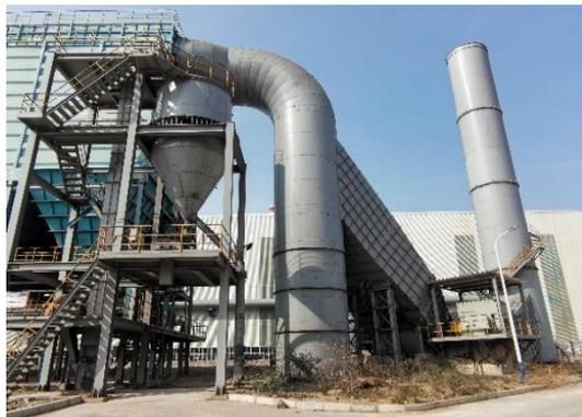
图 4.1—64 铸铁机系统除尘
