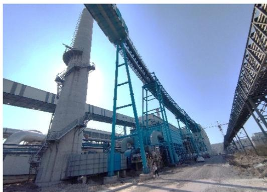
图 4.1-17 烧结机配料除尘系统（2 套）
