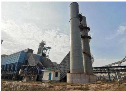
图 4.1-49 2#高炉出铁场除尘（2套）
