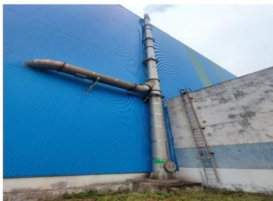
图 4.1-108 连退机组清洗段碱雾净化
