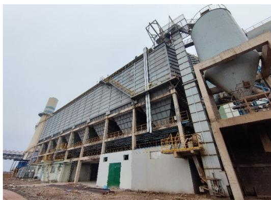
图 4.1—71 炼钢一车间转炉三次除尘
