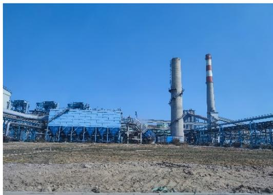
图 4.1—18 烧结机成品除尘系统（2套）
