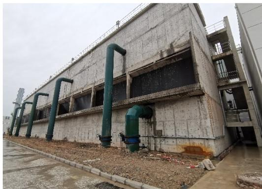
图 4.1-146 热轧带钢水处理冷却塔
