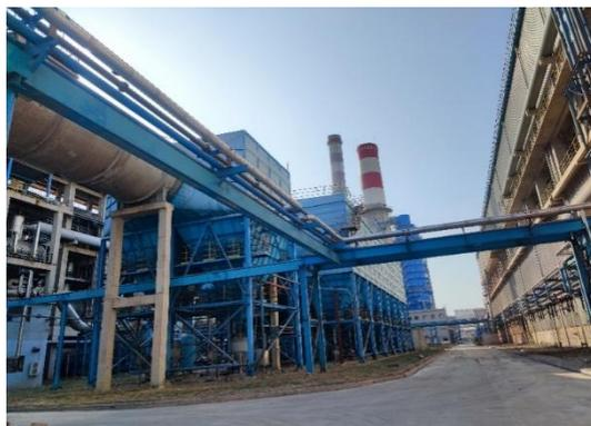
图 4.1-16 2 号烧结机机尾烟气除尘
