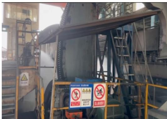
图 4.1-6 翻车机基坑洒水抑尘设施
