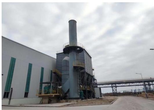
图 4.1-134 钢渣破碎磁选车间布袋除尘系统
