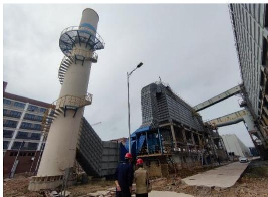
图 4.1—75 炼钢地下料仓及转运站系统除尘
