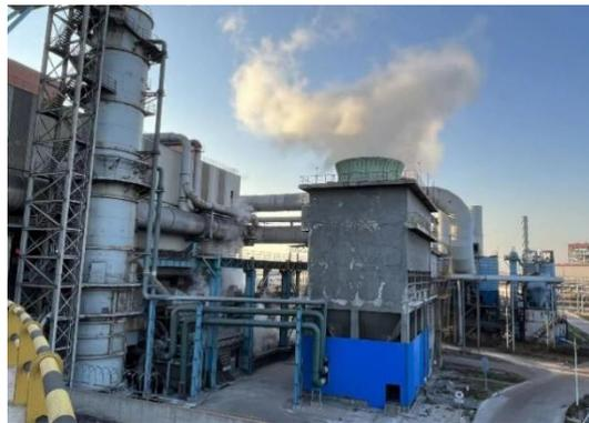
图 4.1-139 炼铁厂冲渣水循环系统
