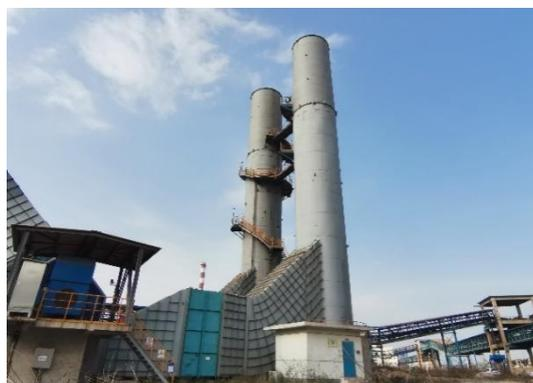
图 4.1-48 1#高炉出铁场除尘（2套）
