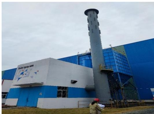
图 4.1-104 冷轧酸洗机组拉矫、焊接除尘
