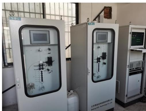
图 4.2-6 废水在线监测设备
