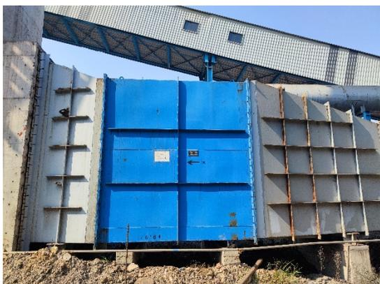
图 4.1—170 除尘风机消声器
