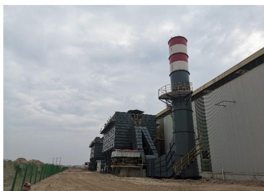
图 4.1-135 金材废钢切割除尘（2 套）
