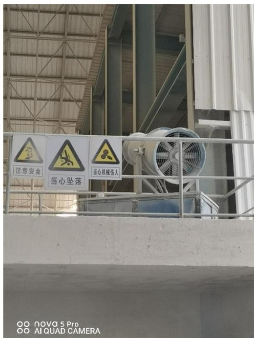
图 4.1—76 石灰厂原料除尘系统（水雾抑尘系统）
