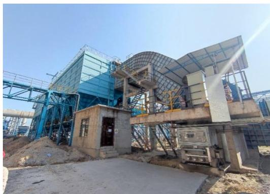
图 4.1-15 1 号烧结机机尾烟气除尘
