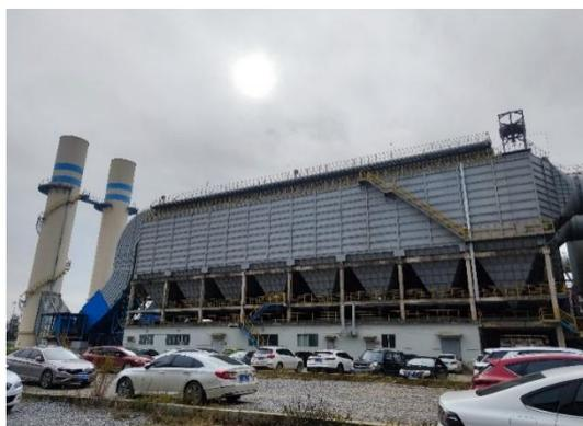
图 4.1—70 转炉二次烟气除尘
