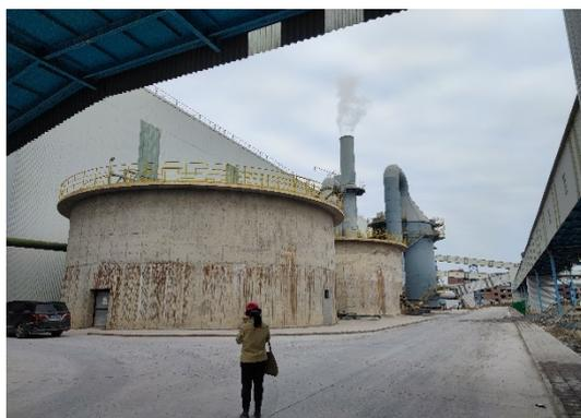
图 4.1—152 钢渣处理废水处理系统
