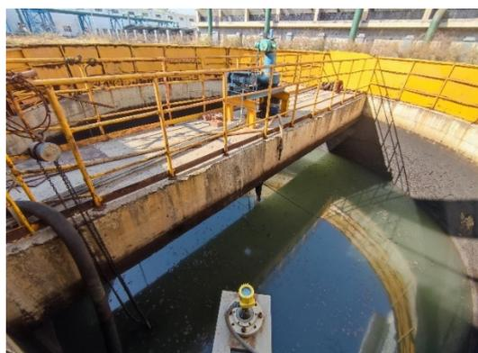
图 4.1-144 连铸浊环水污泥沉淀池
