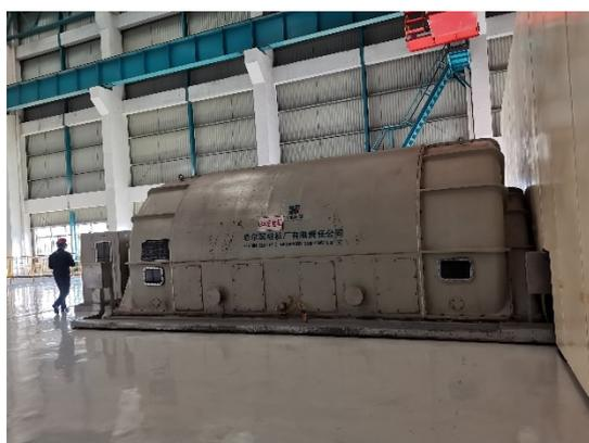
图 4.1—173 发电机设置隔声罩
