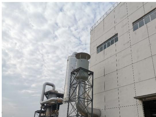
图 4.1—171 气体放散消声器
