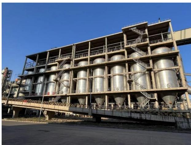
图 4.1—63 2号高炉煤气干法除尘
