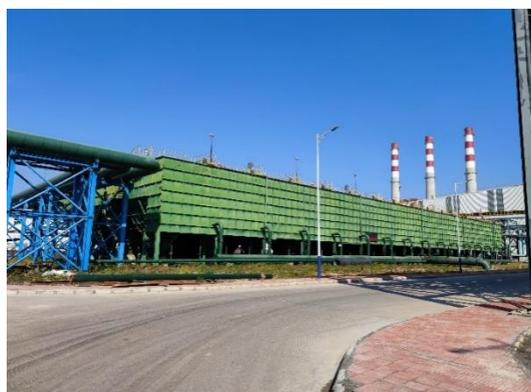
图 4.1-143 连铸浊环水化学除油器
