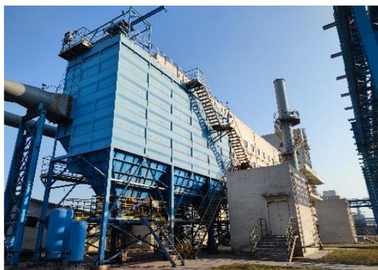
图 4.1—27 辊压配料除尘系统
