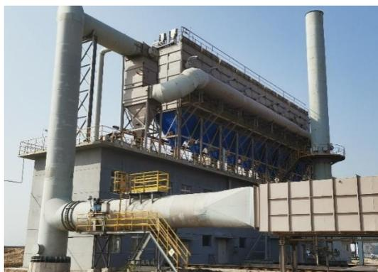
图 4.1-40 1#推焦机侧除尘系统
