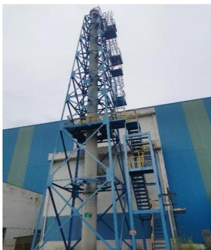
图 3.6—101 冷轧酸洗机组酸洗段、漂洗段废气净化
