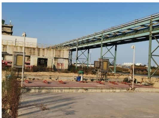
图 4.1-159 焦化厂化产区消防事故水收集池
