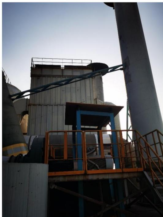
图 4.1—65 原煤卸料点除尘系统
