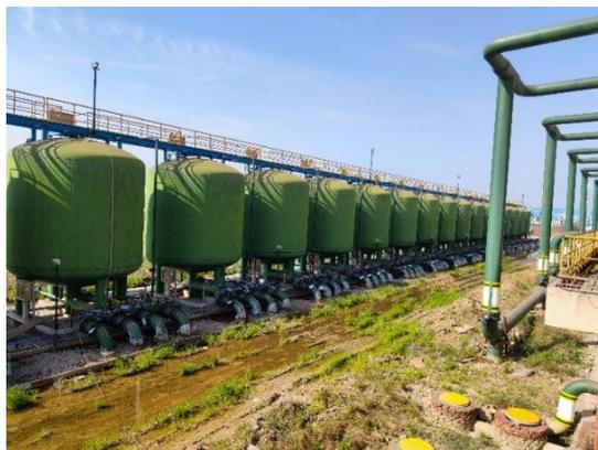
图 4.1-142 连铸和 RH 浊环水系统过滤器
