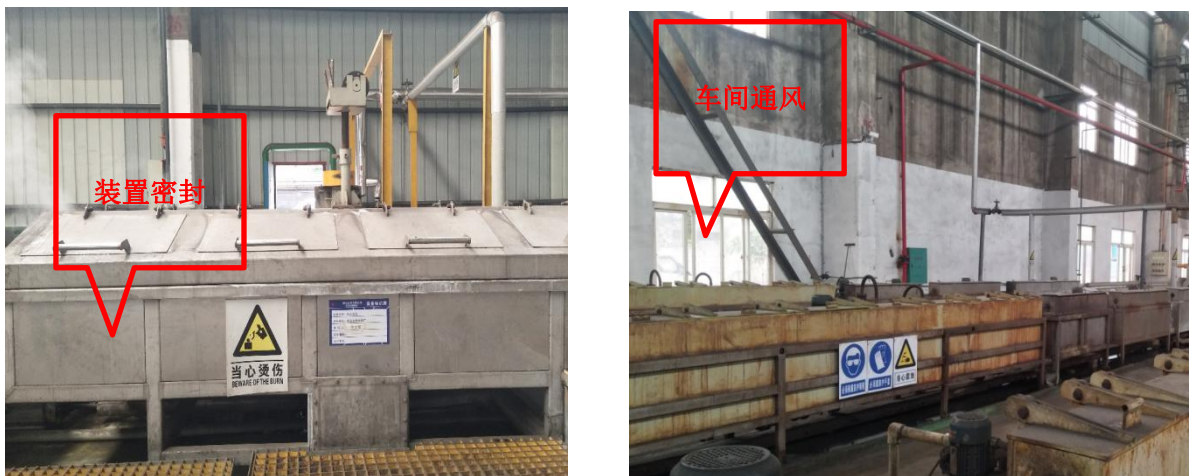
图 3-10 无组织废气处理措施
