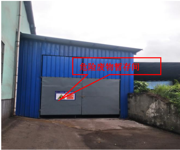
危险废物暂存间
