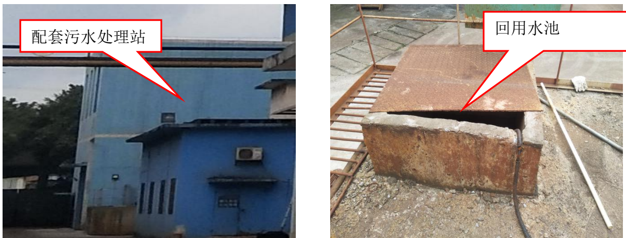
图 3-2 配套污水处理站及废水排口
