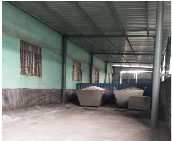
危险废物暂存间内部
