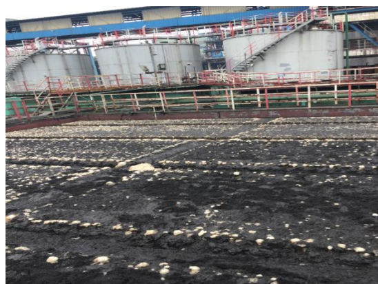
项目新增调节池水槽
