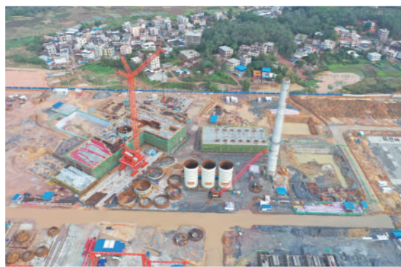
←建设中的镍铁冶炼项目一期1680m 3 高炉（2020年3月）
