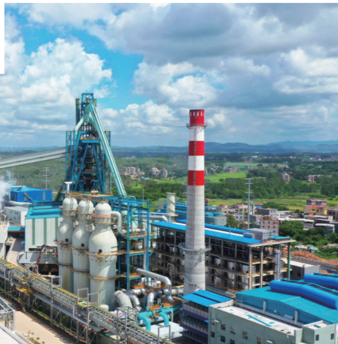
↓具备投产条件的镍铁冶炼项目一期1680m 3 高炉（2021年5月）
