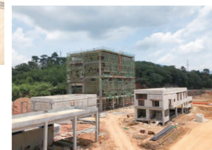
制煤楼建设初期（2020年7月）
