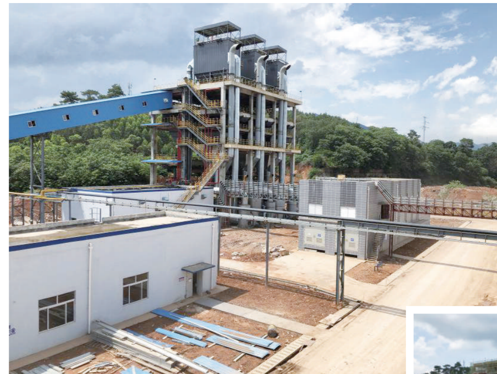
制煤楼新貌（2021年4月）
